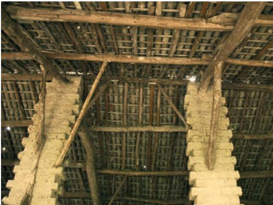
Tettoia della Casa Santini di Ottiglio, con orditura alla lombarda, sostenuta da pilastri centrali senza catene ma con rinforzi sghembi a un quarto della discesa. La larghezza della falda in discesa è di oltre 6 metri, senza catene, su un muro esterno in pietra da cantoni e su pilastri fatti da strati di quattro cantoni su un'altezza di trenta corsi. Costruita intorno agli anni '30 del secolo scorso.
